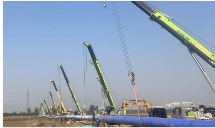
河北保定江水置换工程
