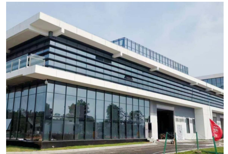
广州荔湾龙归通沟余泥处理站工程
