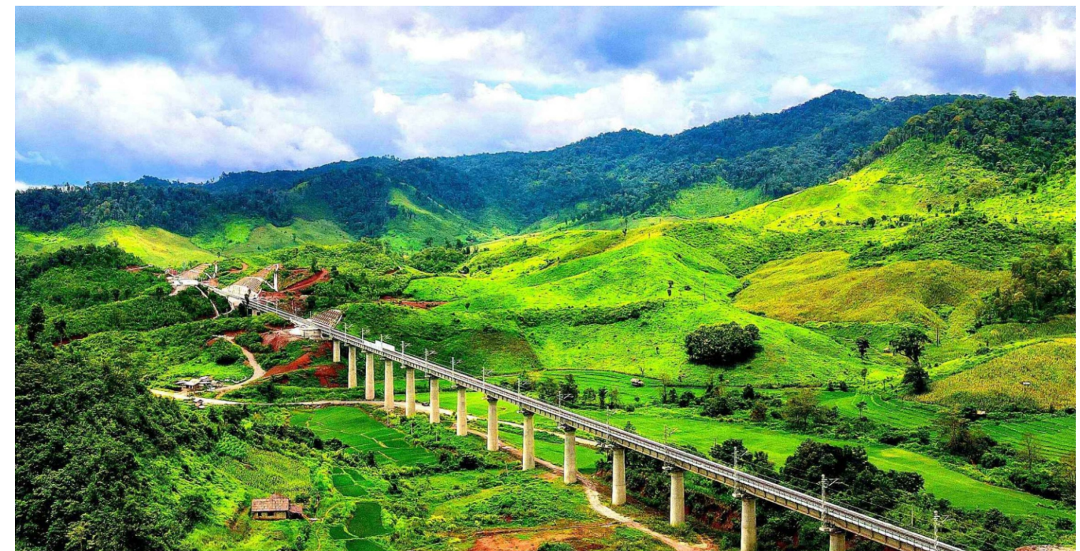
中老铁路楠暖河特大桥
