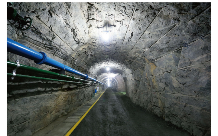
草楼铁矿井下巷道光面爆破
