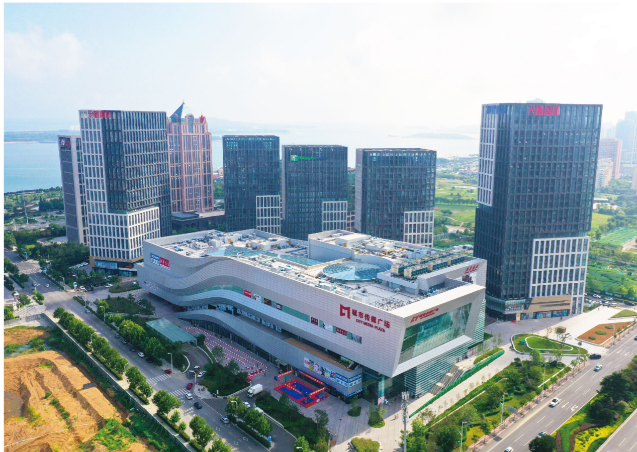
青岛数字传媒中心工程 Qingdao Digital Media Center Project
