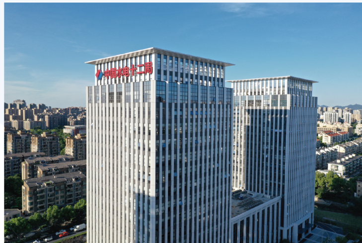
中国水电十二局科研综合楼
