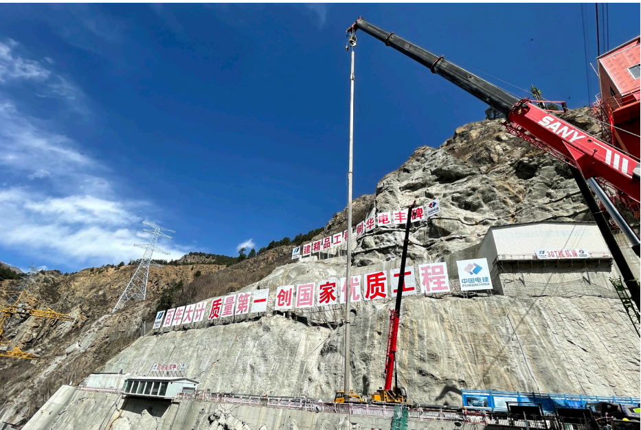
◎ 西藏DG水电站大坝取出长26.2米、直径20厘米的三级配碾压混凝土芯样，一举打破了同类芯样长度世界纪录，反映了水电九局碾压混凝土施工技术、质量和工艺达到了国际领先水平，该芯样被国家博物馆收藏。
