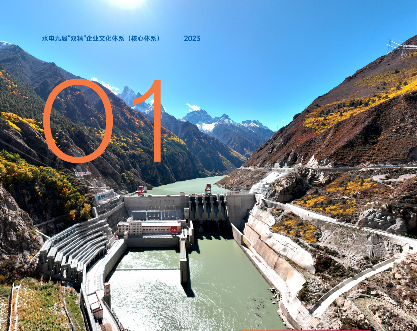
◎ 西藏大古水电站，总装机容量66万千瓦，为西藏最大的内需水电站，大坝为世界海拔最高碾压混凝土重力坝。
