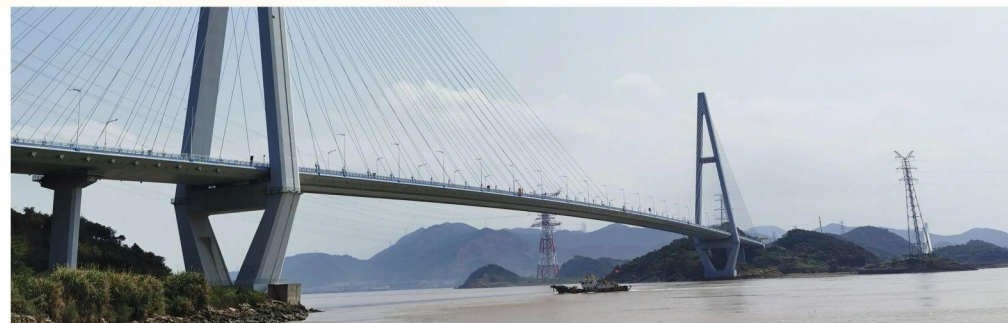
■ 浙江舟山跨海大桥
