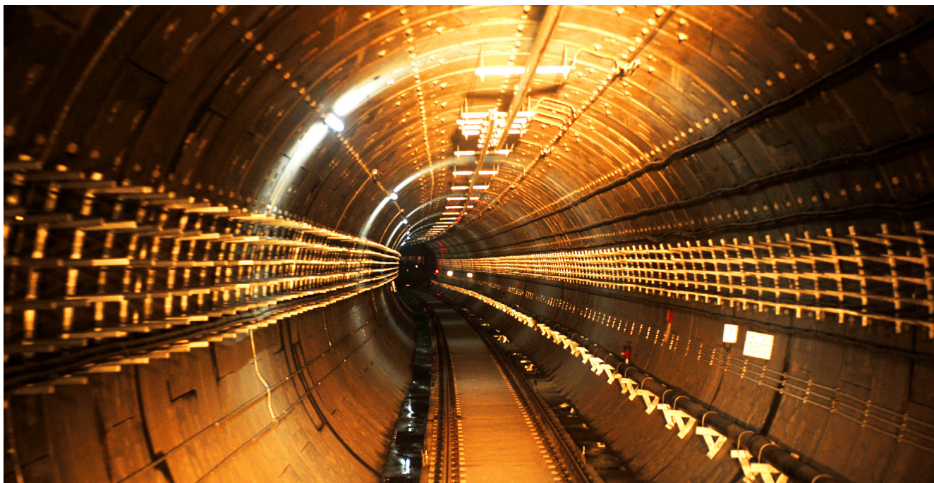
青岛市地铁8号线PPP项目 Metro Line 8 Project in Tsingtao City (PPP)
