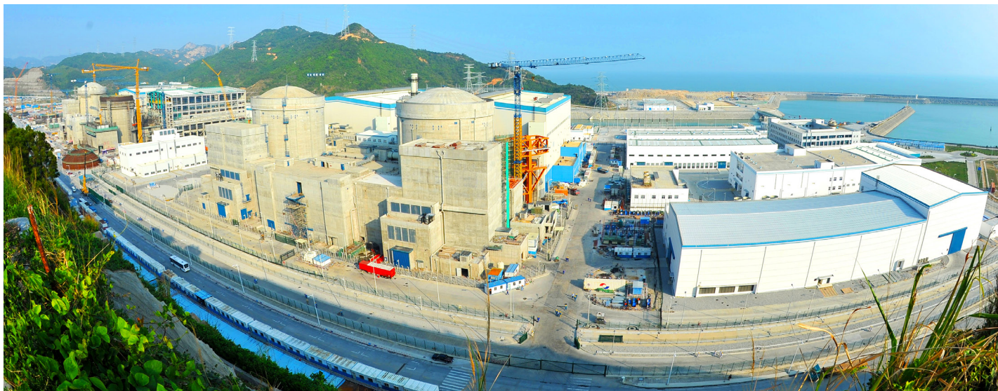
阳江核电站一期工程1&2号机组明渠、3-6号 机组明渠工程 Yangjiang Nuclear Power Plant Engineering (Phase I)
