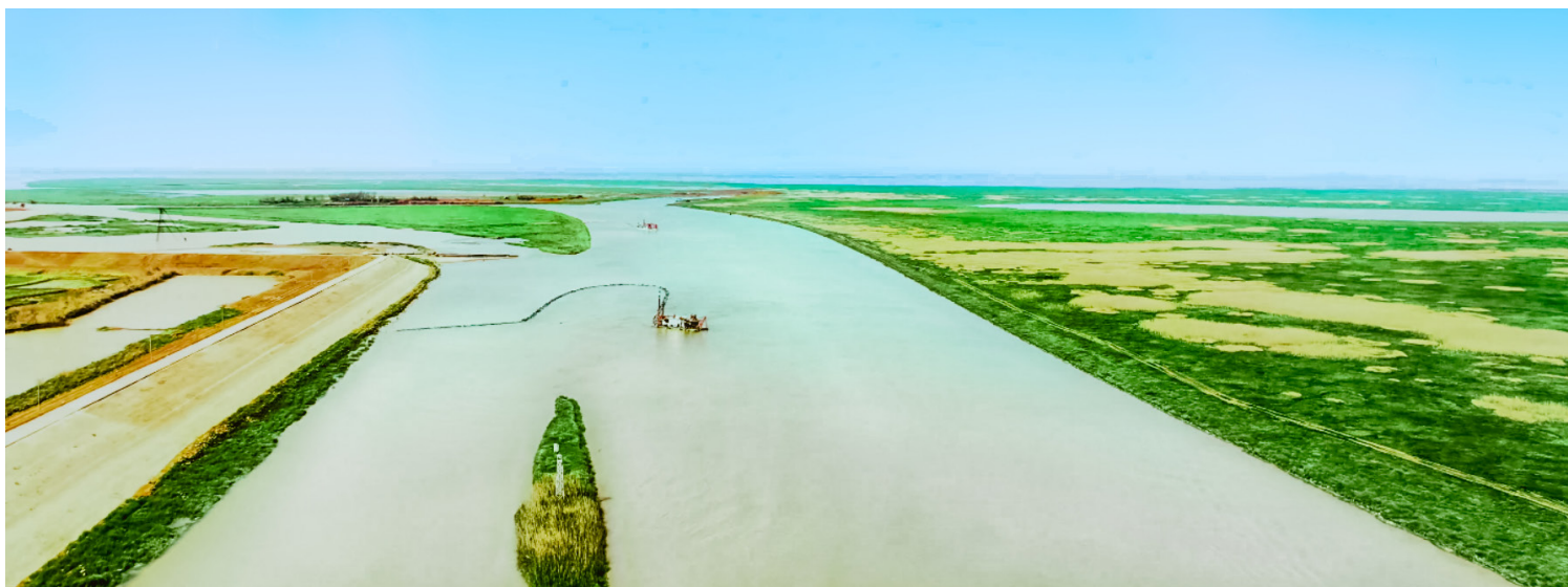
江西信江高等级航道整治工程 主体土建工程 Main Civil works of Jiangxi Xinjiang High- grade Waterway regulation project
