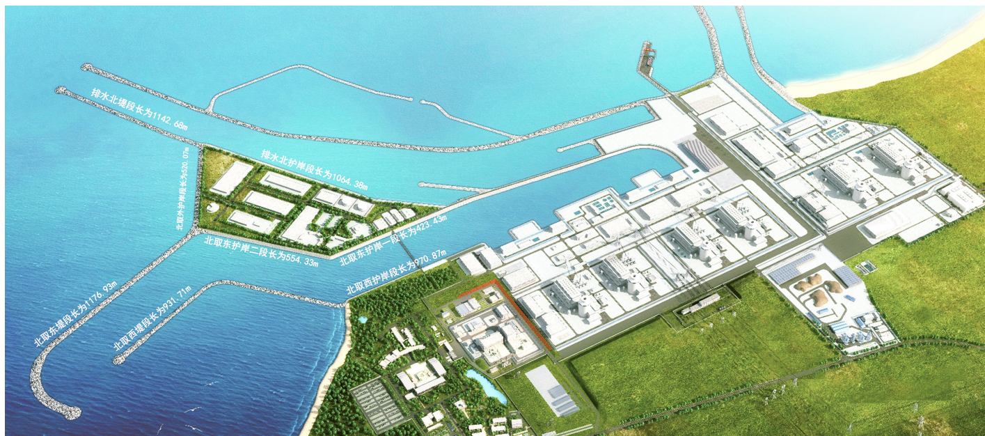
华能石岛湾核电厂取排水工程
