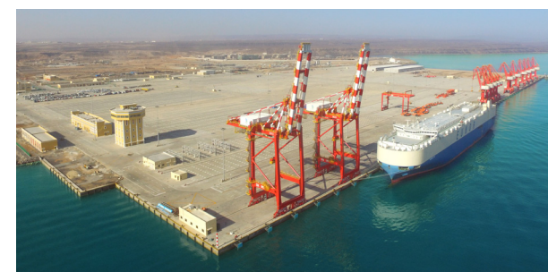
吉布提多哈雷多功能港口 (一期) 工程 Doraleh Multi-purpose Port (Phase I) In Djibouti
