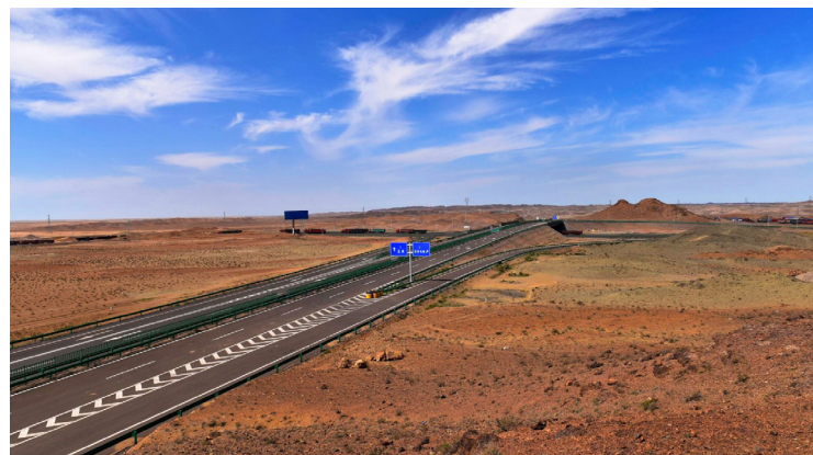
国道242甘其毛都至临河一级公路工程 G242 First Class Highway Construction Project
