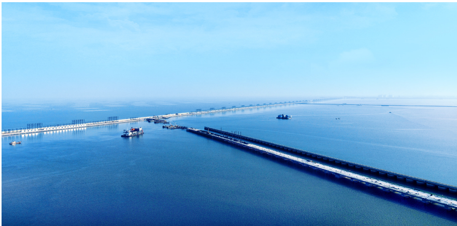
连云港港徐圩港区斜坡式结构东防波堤工程
