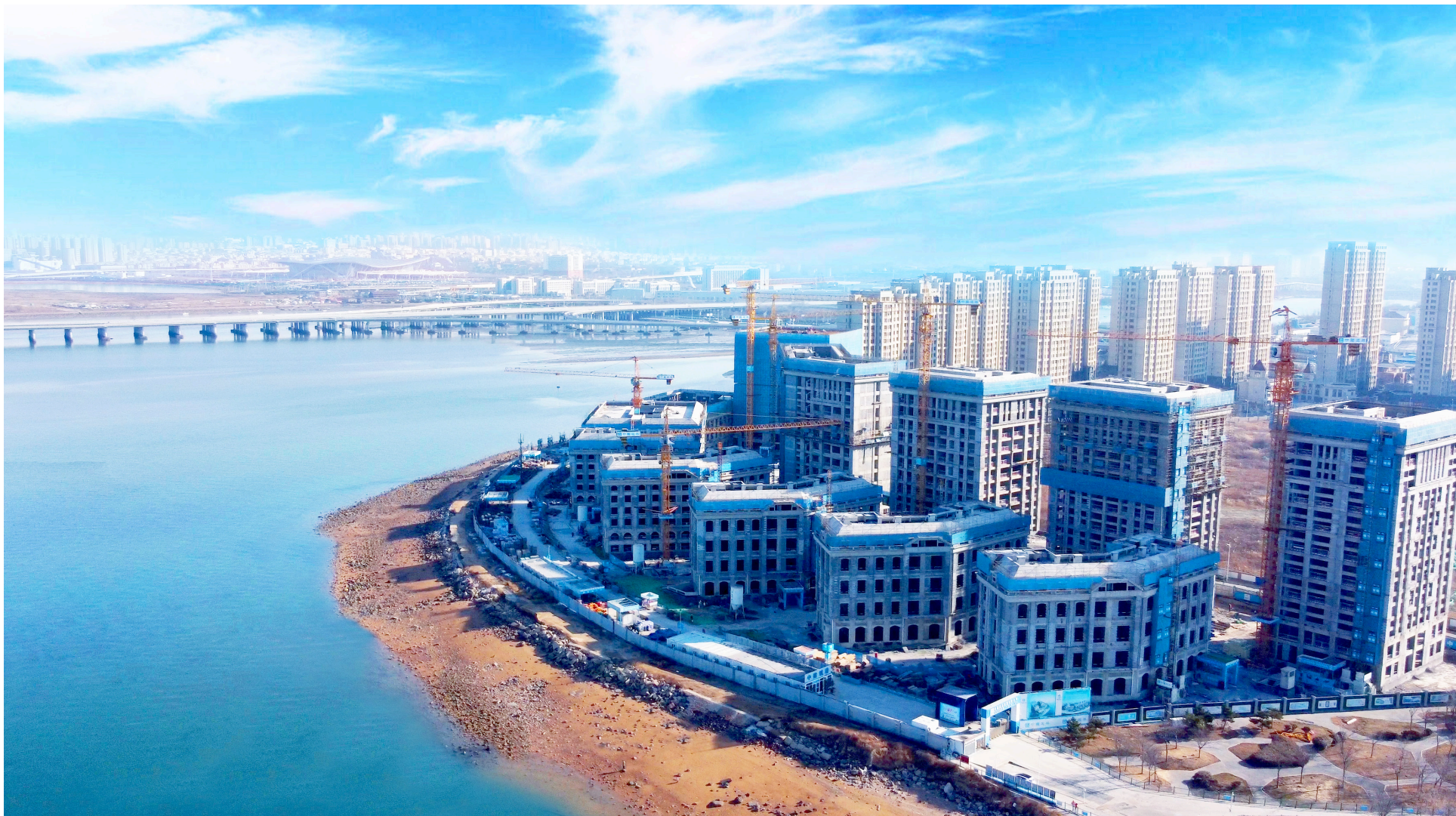
中国钢研“一院一园”工程（“山东省建筑工程优质结构”奖） China Steel Research Institute ( Provincial Quality Award )
