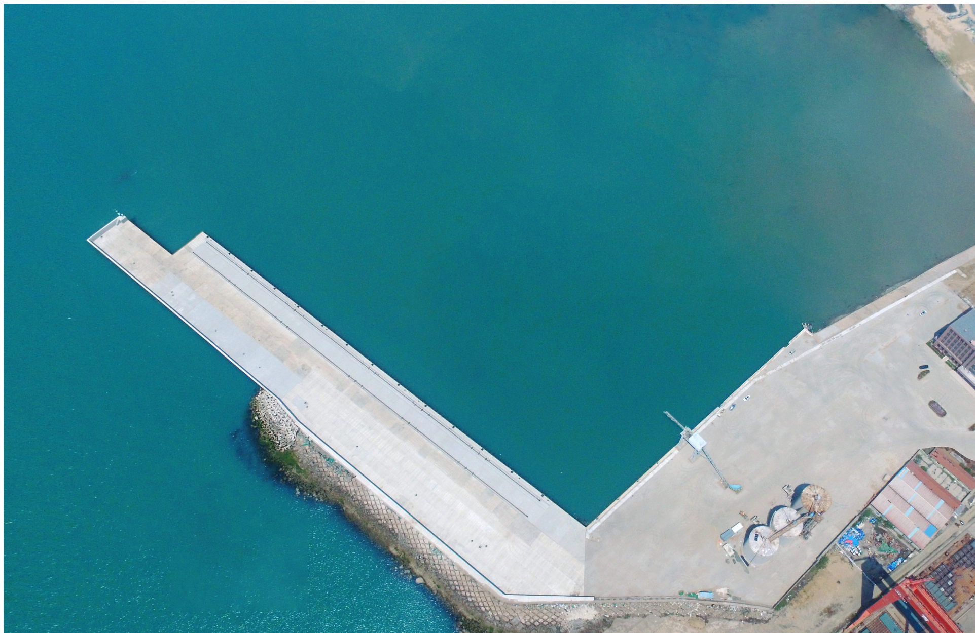
女岛港升级改造工程（一期、二期） Tsingtao Nvdao Port Upgrading and Renovation Project ( Phase I & II )
