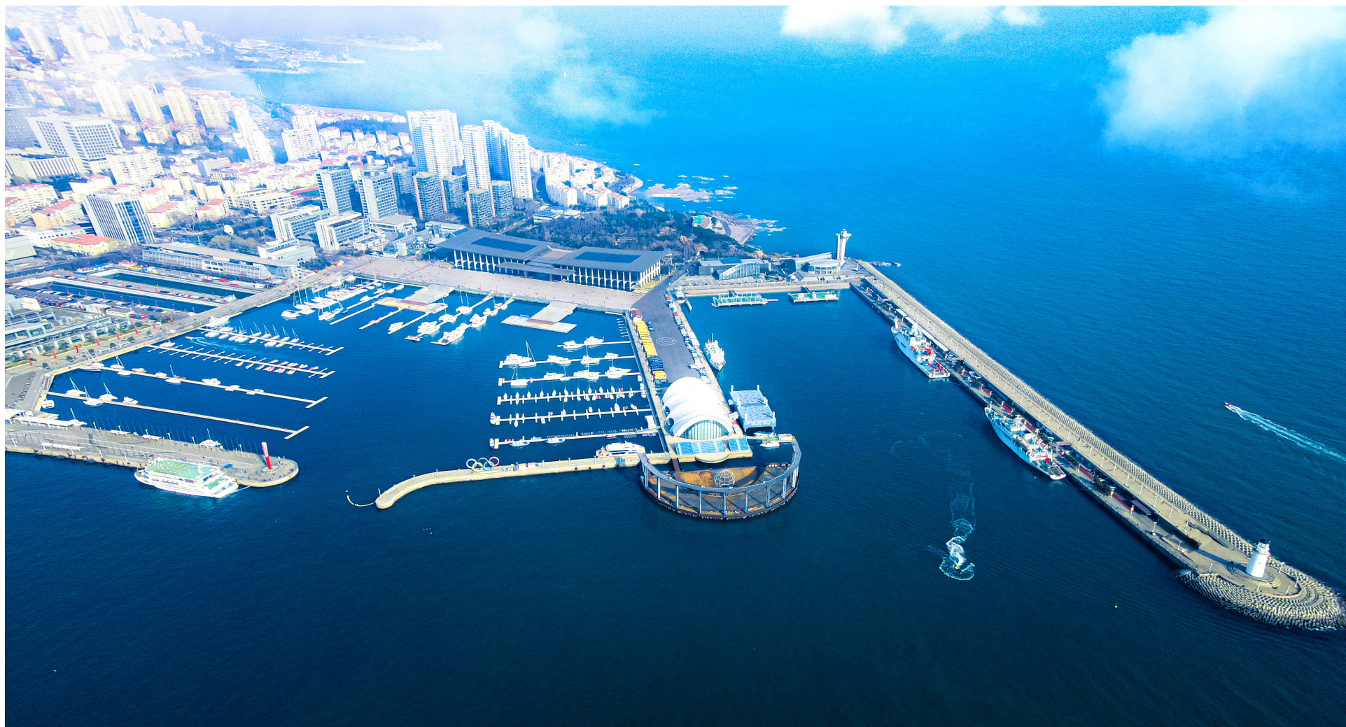
第29届奥运会青岛国际帆船中心水工工程（鲁班奖） Sailing Center for 29th Olympic Games (The Luban Prize)
