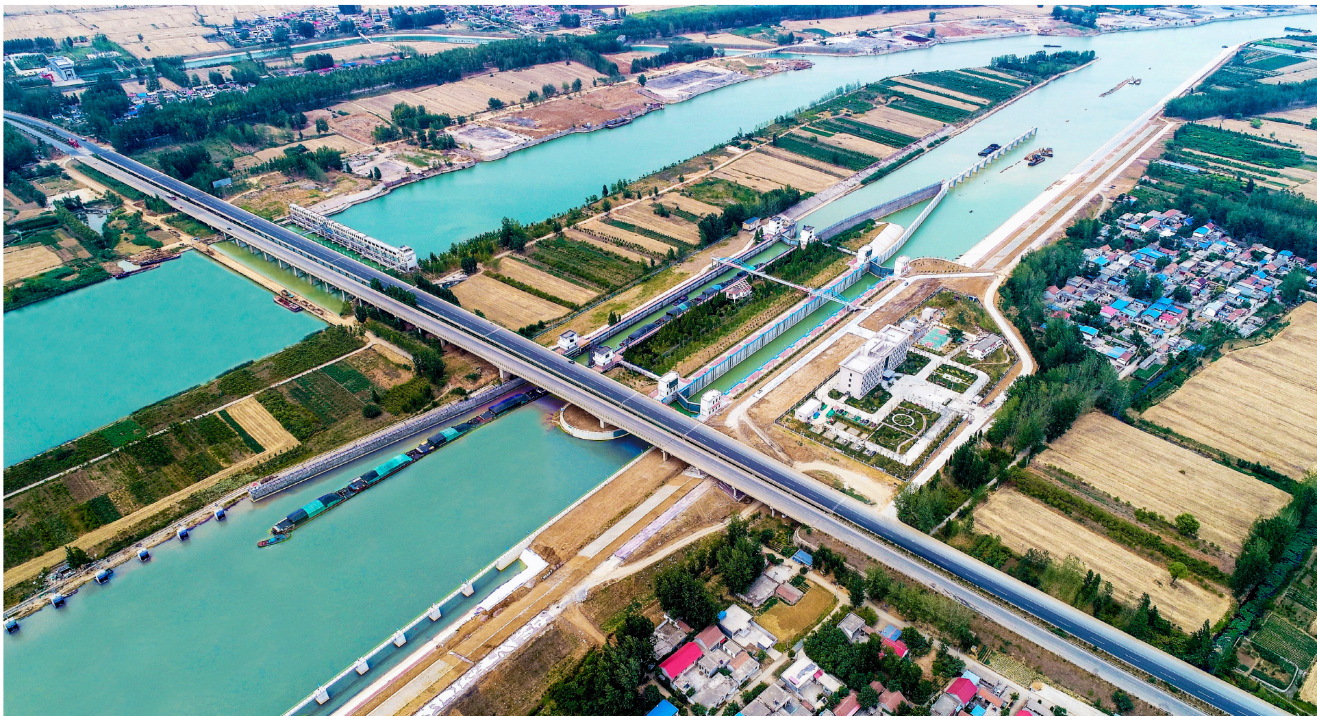
京杭运河续建工程万年闸枢纽工程
