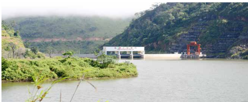
南俄5水电站库区
