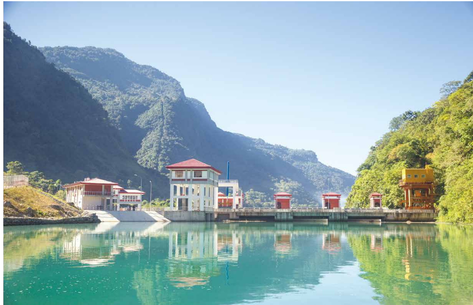
上马相迪 A 水电站
