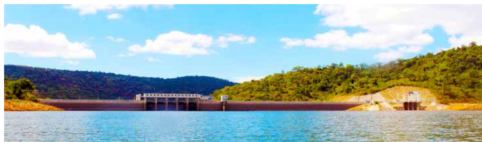
甘再水电站全景
