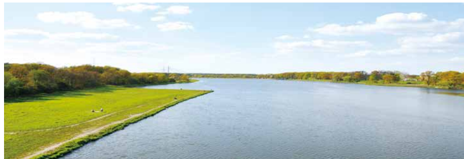
中国电建波兰弗罗茨瓦夫防洪项目—TASK6 河道
