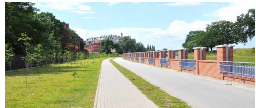
中国电建波兰弗罗茨瓦夫防洪项目—TASK5 防洪墙
