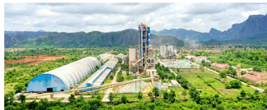
老挝水泥厂全景
