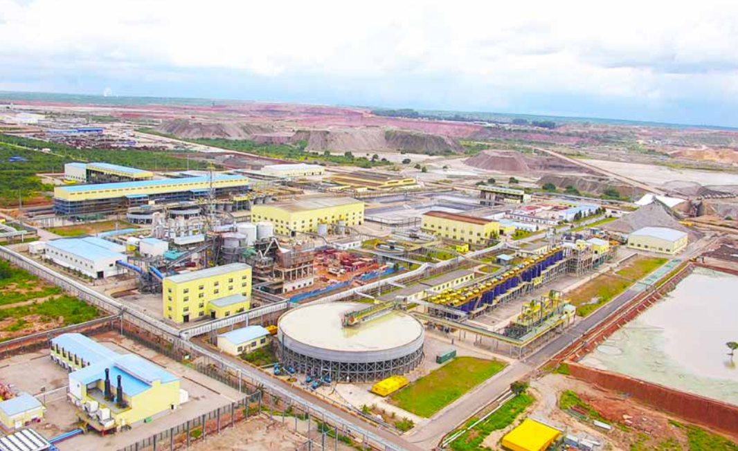
华刚矿业选冶厂区
