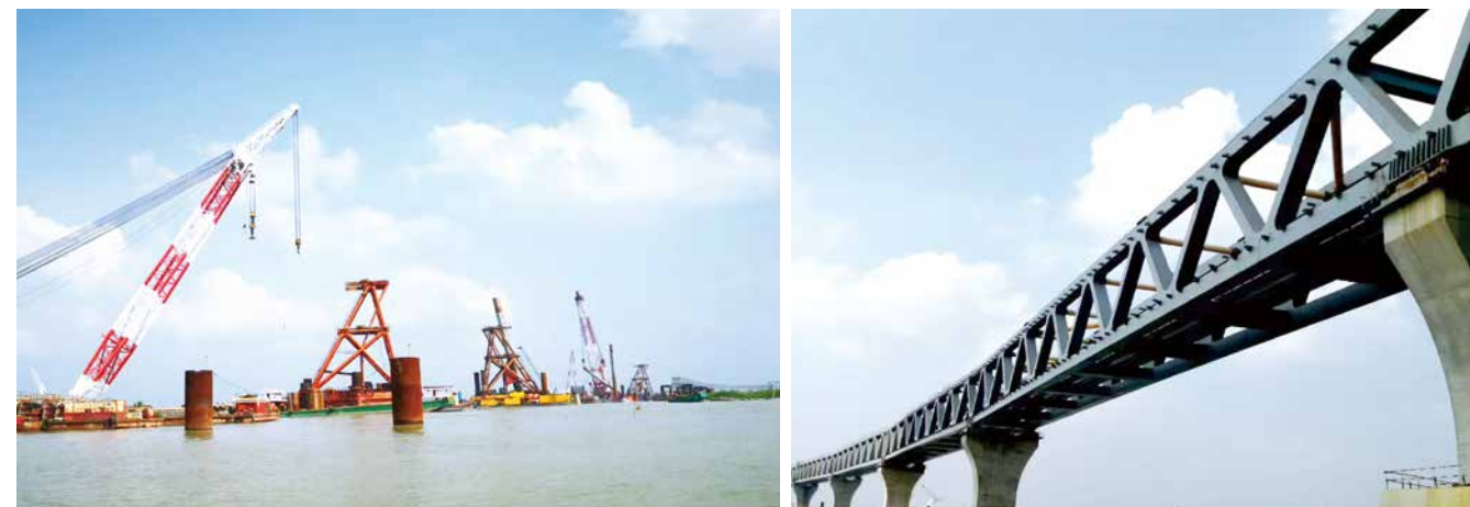
中国电建承建孟加拉 Meghna River 大桥
