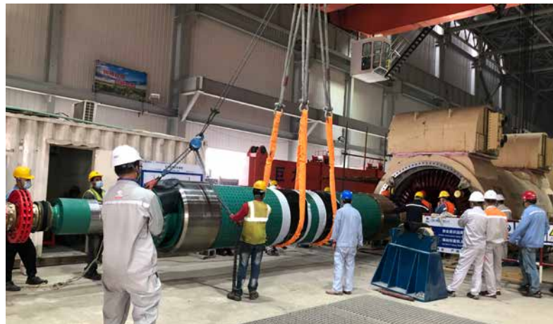
2022年1月17日巴瑞萨电站项目发电机转子穿装顺利完成
