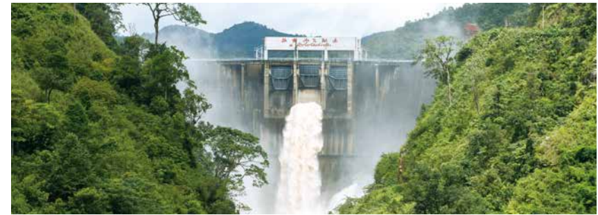
南俄5水电站全景
