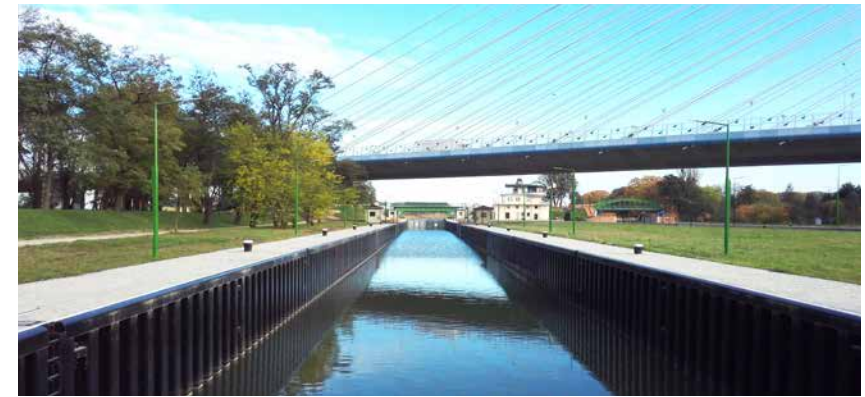
中国电建波兰弗罗茨瓦夫防洪项目—TASK7北船闸
