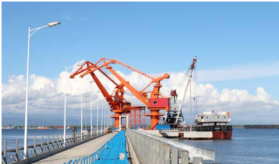
建设中的明古鲁电站码头
