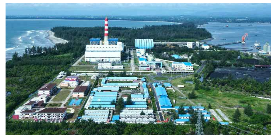
明古鲁电站建设现场
