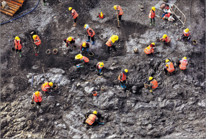
2024年10月15日,在平陆运河马道枢纽工程工地,工人正在人工清理运河底部软性物质。 本报记者 杨登峰 摄
