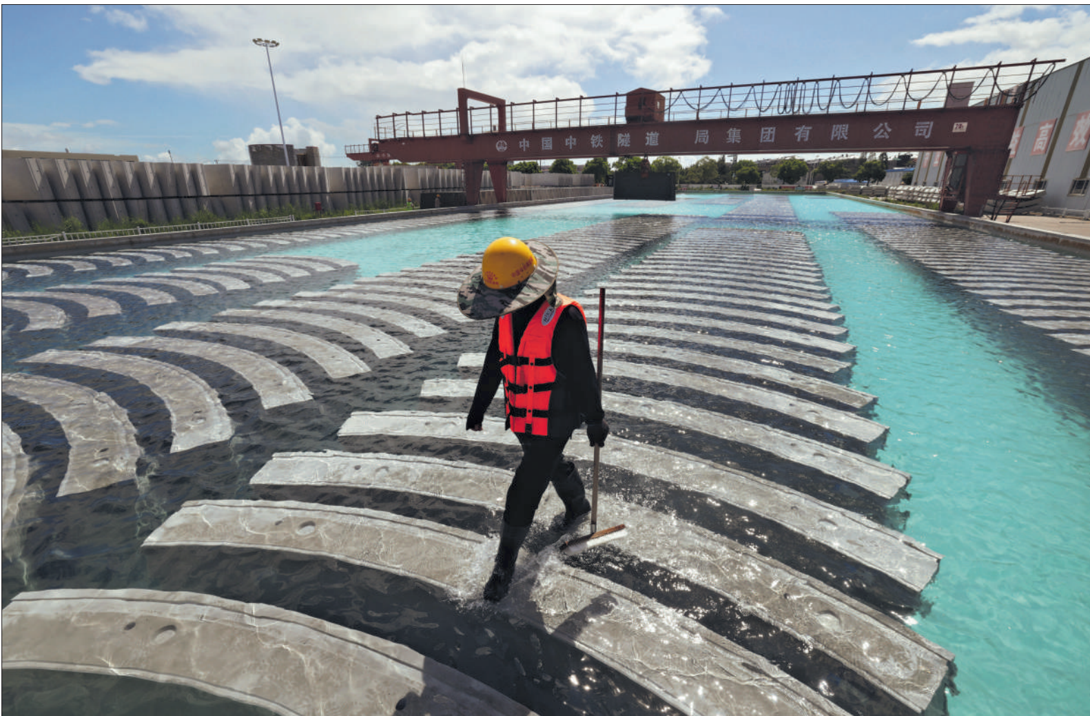
8月20日,崇太长江隧道管片厂两米多深的水养池内,一名工人正在检查整齐排列的管片。每一环管片经蒸养、水养后,才运往江底拼装成隧道。
