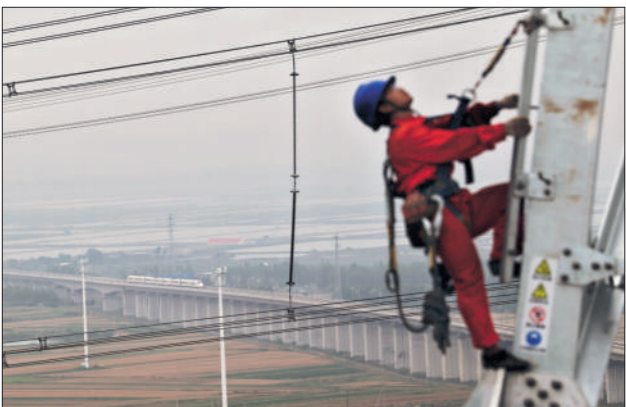
6月21日,一列高铁从正在施工的电塔旁边驶过。
