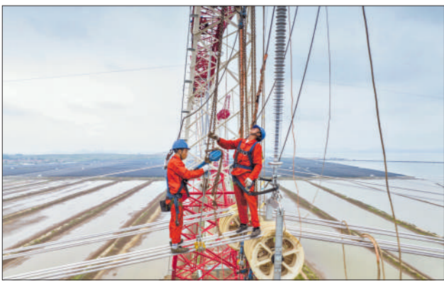
6月22日,电力工人开展线路附件安装施工。
