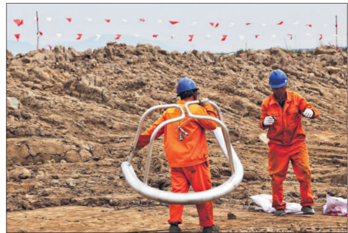
6月21日,工人在搬运即将被吊上电塔的设备。
