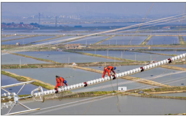
6月20日,电力工人在高空沿绝缘子串作业。
