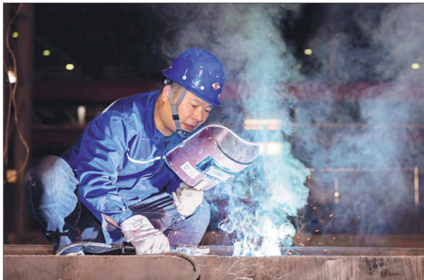
徐永虎在进行焊接作业。
