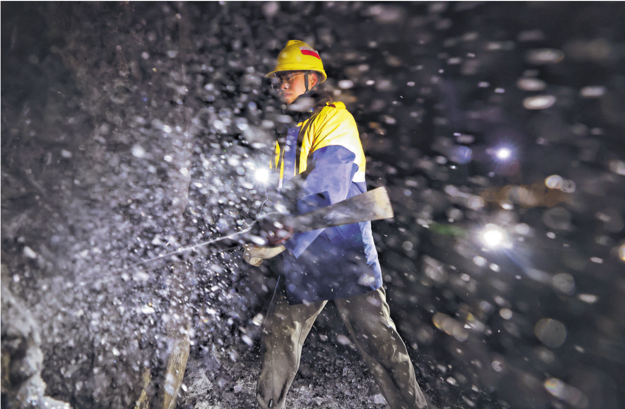
2月5日,河北省承德市滦平县,在京通铁路咽喉要道红旗隧道内,国铁北京局承德工务段金沟屯线路维修工区工人正在用镐除冰。
