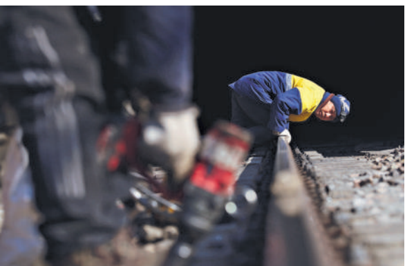
2月4日,鲍有春师傅趴在地上查看钢轨平整度。
