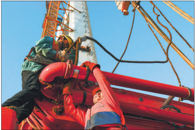
1月14日，两名工人合力将塔吊钢索挂绳穿过待转运的混凝土泵车车身。
