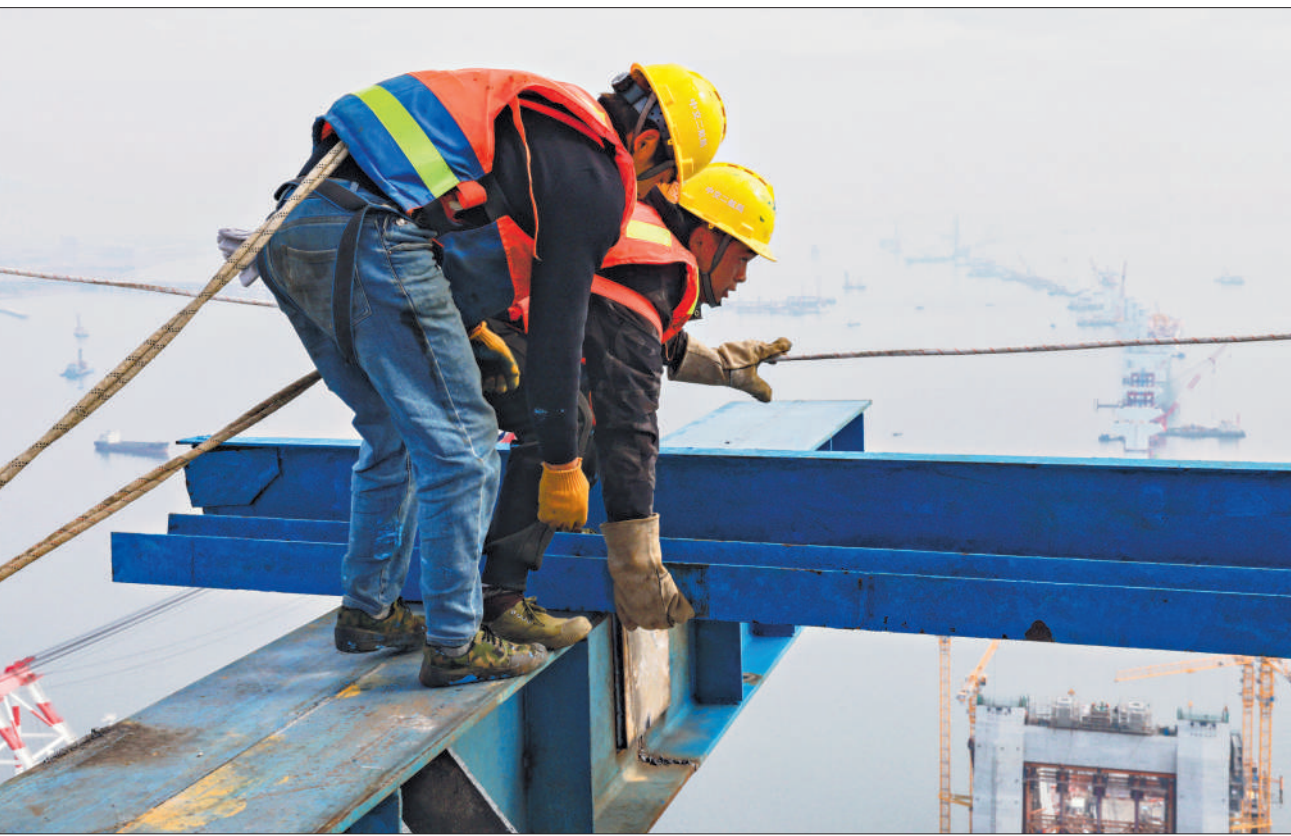
1月15日，在厦金大桥海上作业平台东主塔塔顶170多米处，两名工人合力进行分配梁安装锚固作业。
