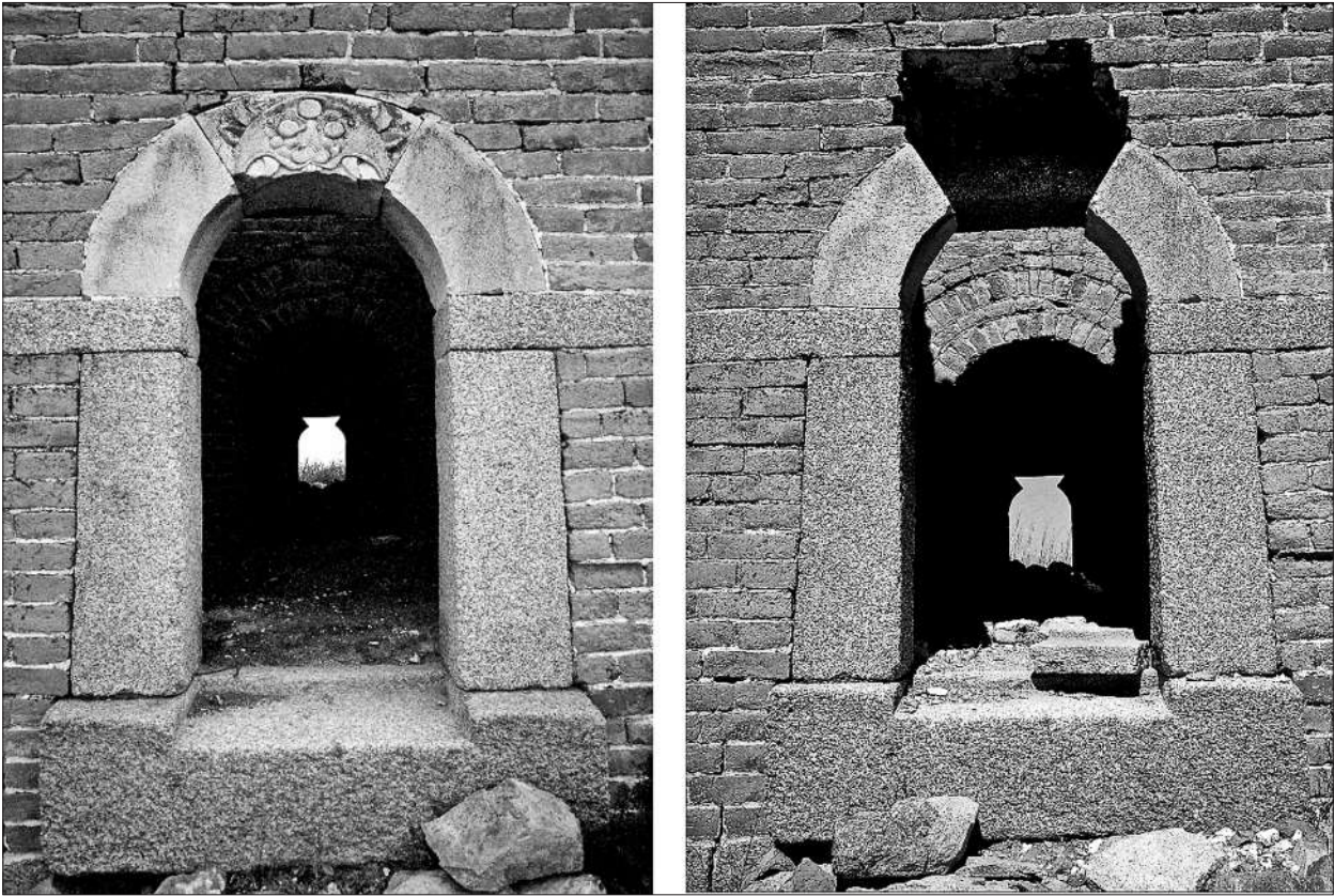
左:2004年拍摄的唐子沟长城的一处敌楼,雕刻成怪兽面目的拱顶石很完整。右:2005年,同一地点拍摄的照片中,拱顶石已消失不见。
