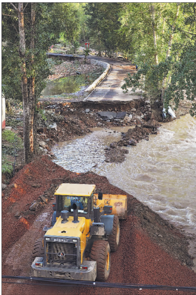
↑7月29日,北京市密云区瓦窑沟桥下,推土机正在抢修被洪水冲毁的道路。
