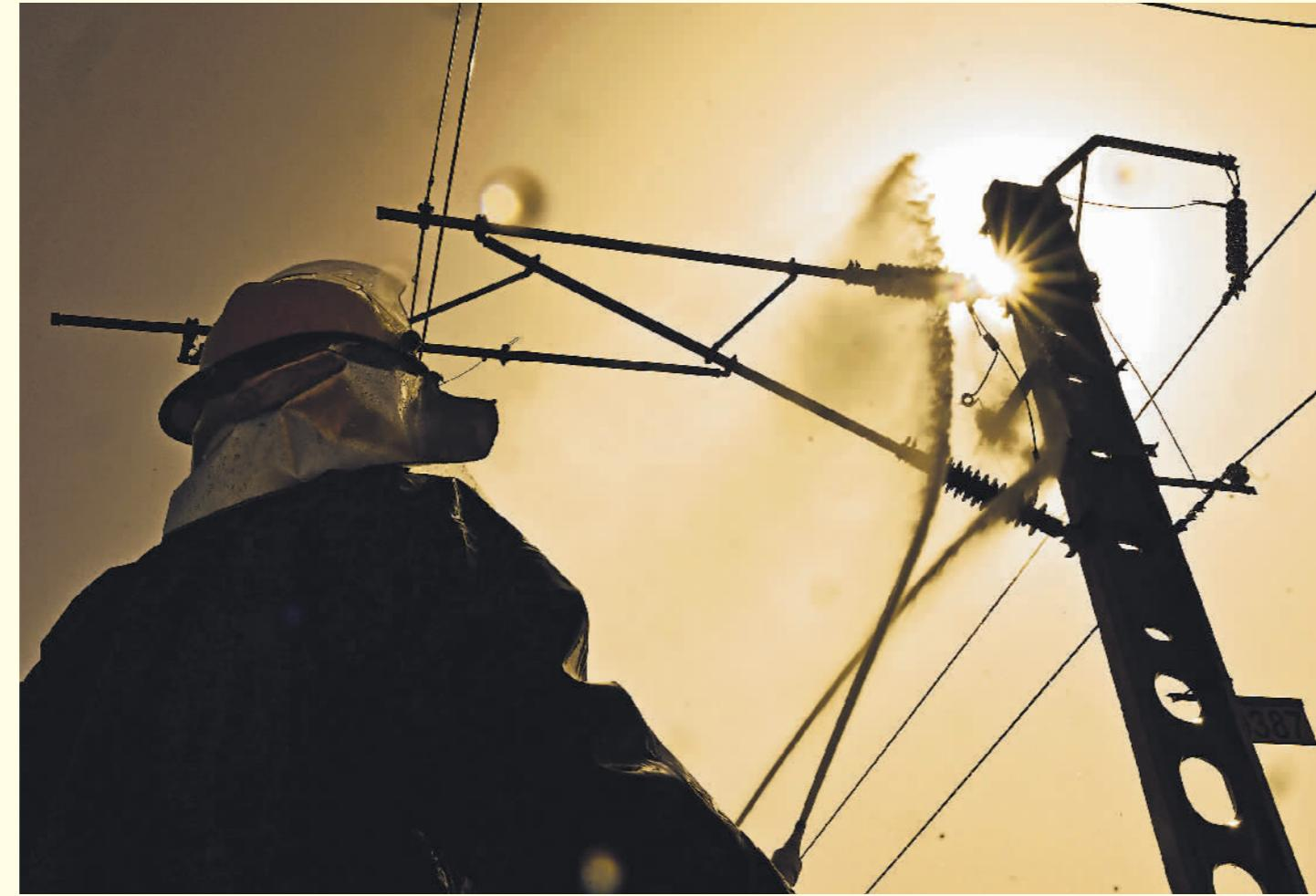
4月16日，中国铁路青藏集团有限公司西宁供电段格尔木供电车间格尔木接触网工区工作人员使用高压水枪清洗接触网绝缘子。
