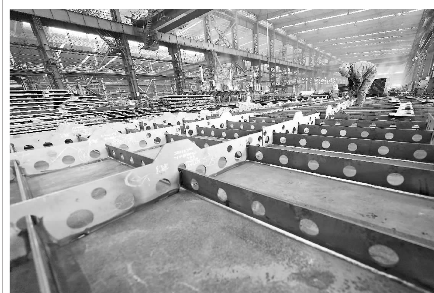
4月1日,中铁山桥集团有限公司的工人在桥梁生产车间工作。
