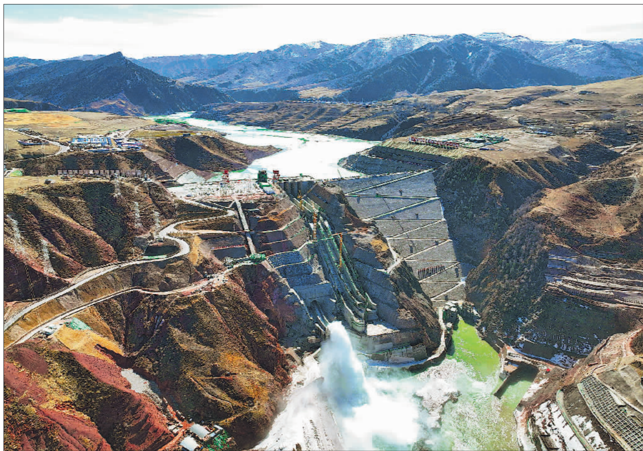
黄河流域在建海拔最高水电站首台机组并网发电
