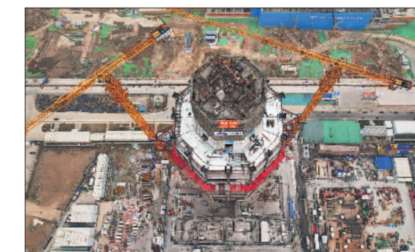
雄安新区中化大厦主体结构封顶
