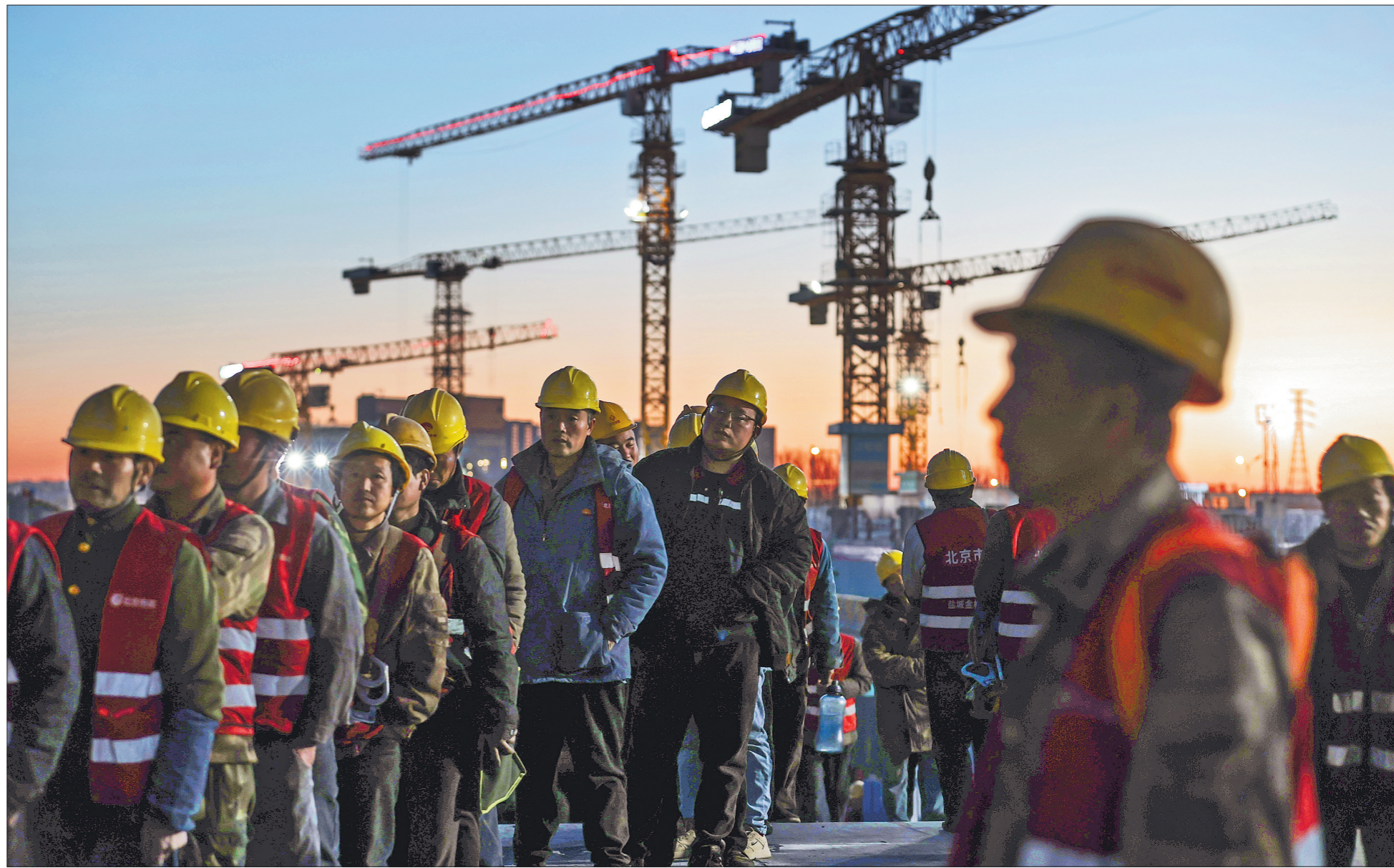
3月20日5时46分,在北京城市副中心站综合交通枢纽工程建设工地,工人们排队登记入场。
