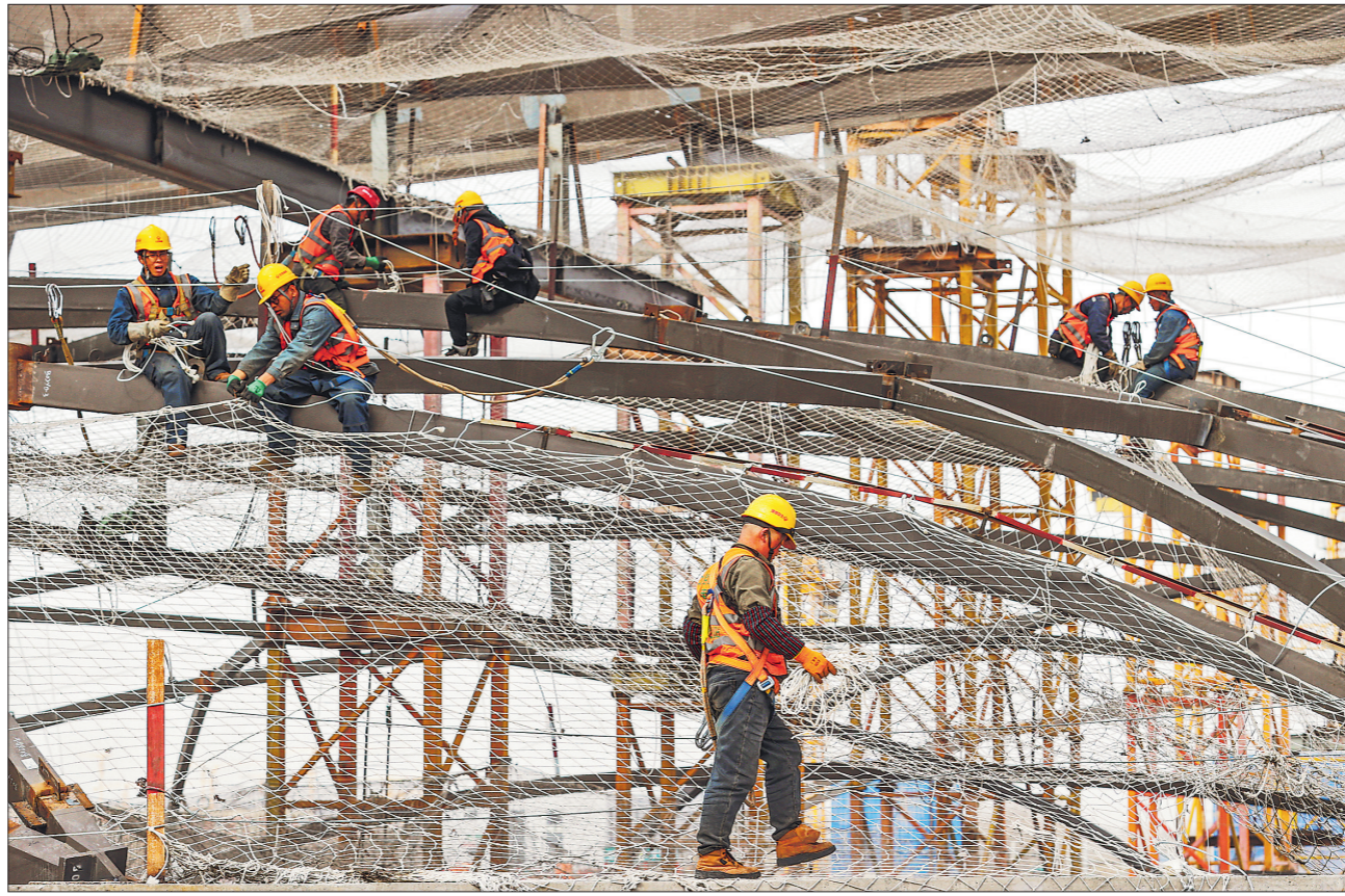
3月16日,在北京城市副中心站,工人们为空中的钢结构作业面铺设防护网,确保施工安全。
