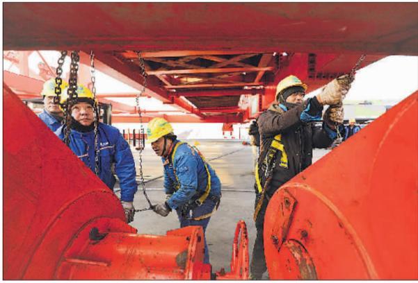
1月27日,工人在大桥高速公路面上解除架桥机后锚固装置。
