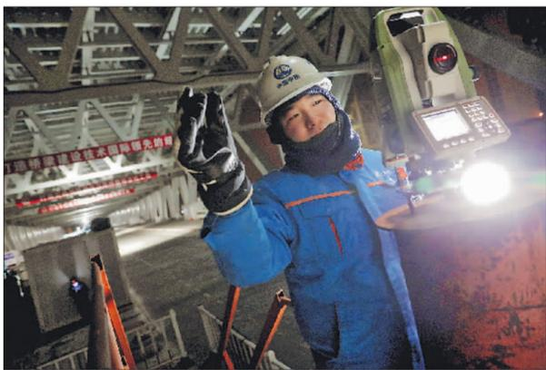
2月1日晚,测量人员在大桥铁路面进行夜间测量。因夜间温度低,大桥钢梁伸缩变形小,工人一般在晚上10点至凌晨2点进行测量。
