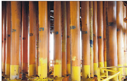
11月22日,番禺4-2B平台上的输油管道,每根管道对应一口井,目前这个平台上有41口油井。
