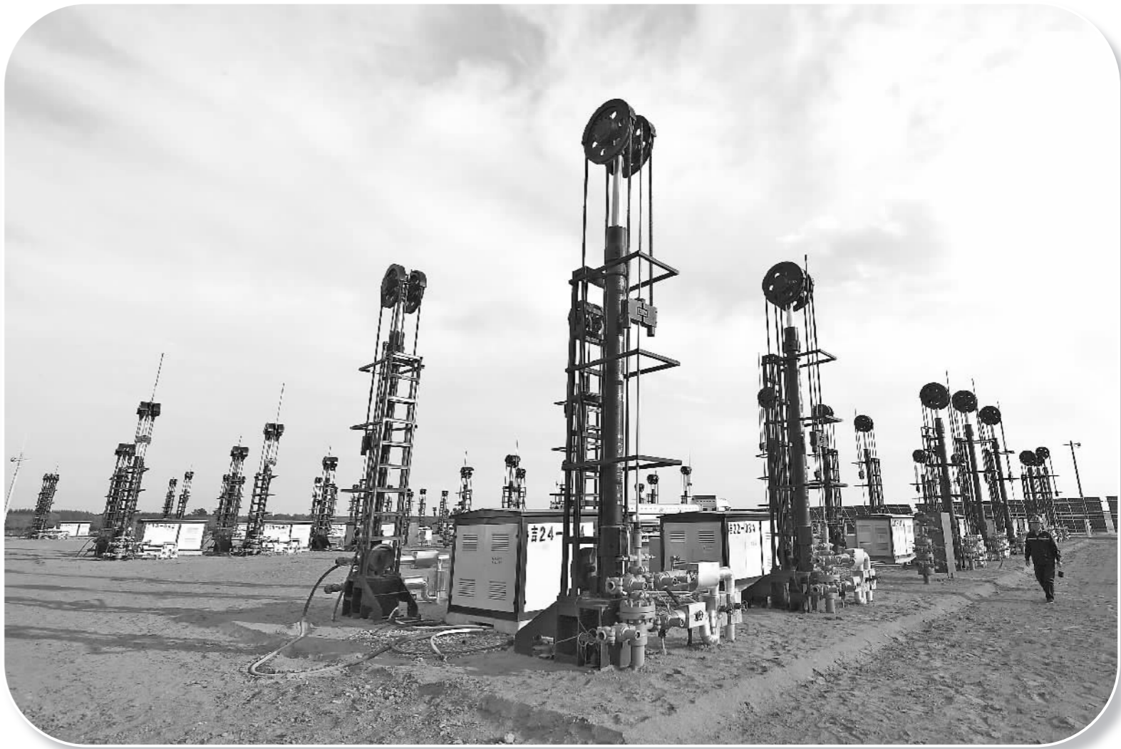
在新立采油厂16号“大井丛”平台,密集打下的72口水井可以采收周边400万平方米范围内的原油。
