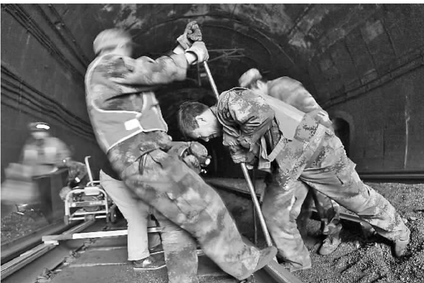
王家湾线路车间的职工在隧道内施工。
