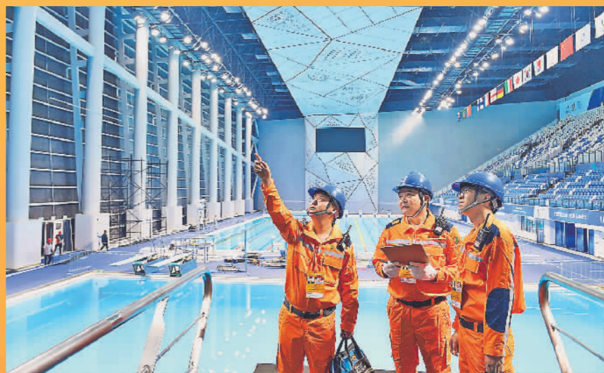
国网四川电力连心桥共产党员服务队对跳水比赛场馆进行巡检。
