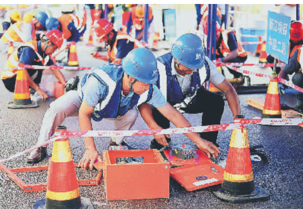
配电箱接线比赛现场。
