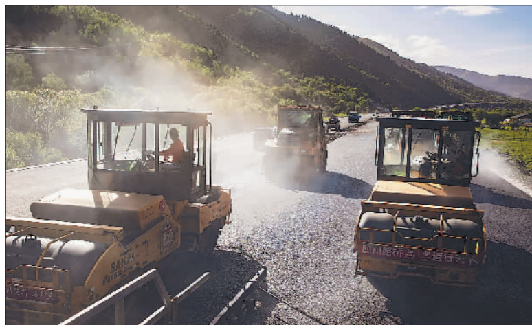
↑6月18日,红原县刷经寺镇,验收合格的土建路段正在进行沥青路面铺装作业。
