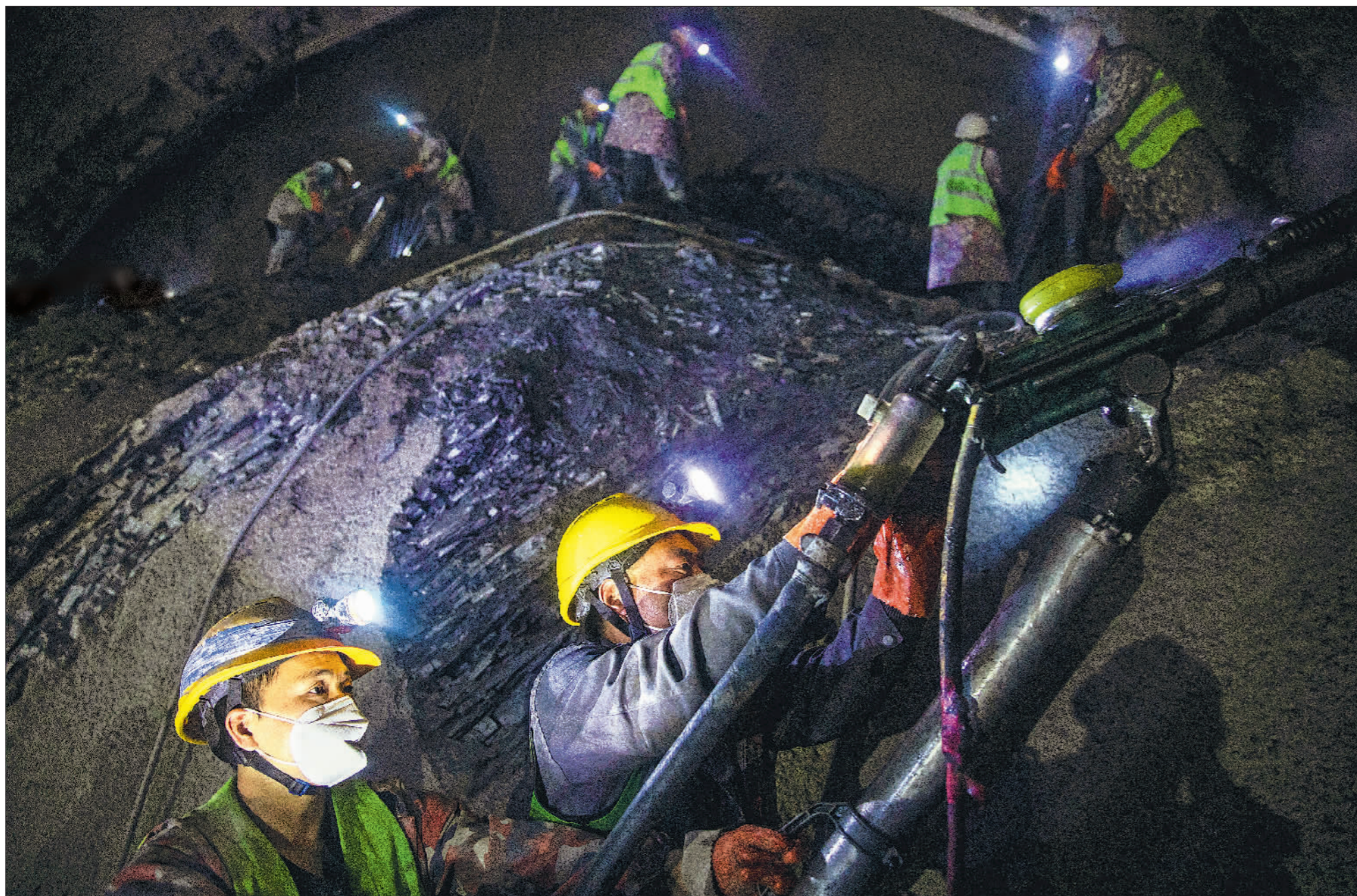
6月19日,四川省阿坝县安羌镇久马高速神座隧道内,工人们正在进行锚索试验段打孔作业。久马高速全线设置隧道20座,神座隧道是其中长度最长、施工难度最大的。
