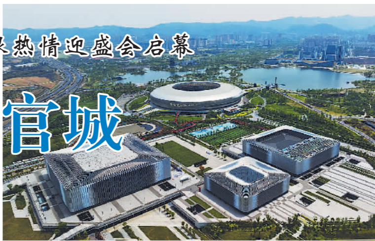
图为成都大运会新建场馆——东安湖体育公园主体育场(后)、多功能体育馆(前左)、游泳跳水馆(前右)和小球馆(前中)。新华社记者 沈铂韩 摄
