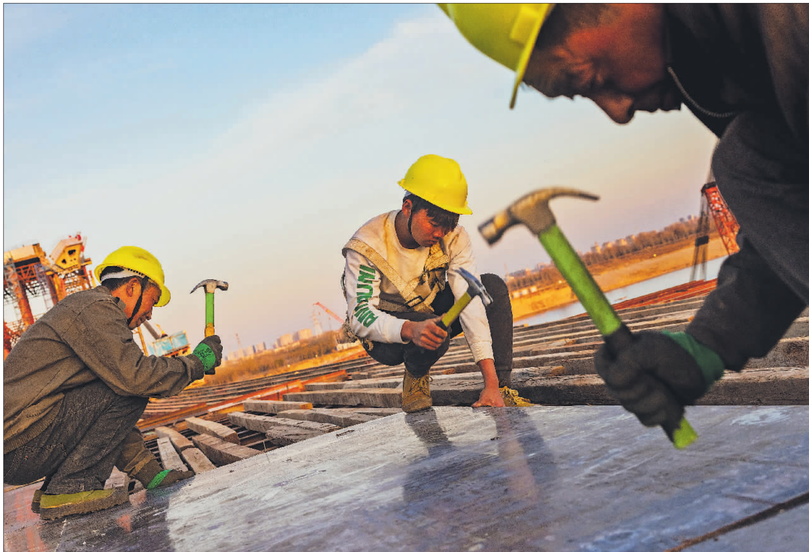
2月28日,来自云南的木工们正在为永定河特大桥铺设混凝土模板。
