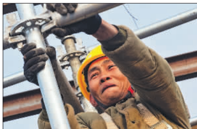
2月28日,一名来自重庆的建设者正在搭建脚手架。
