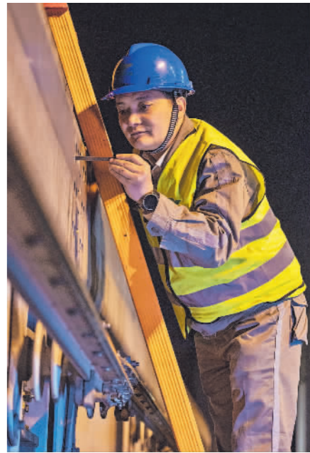
凌晨，张杰在进行单轨道岔钢梁连接部位检查。 本报记者 李国 摄
