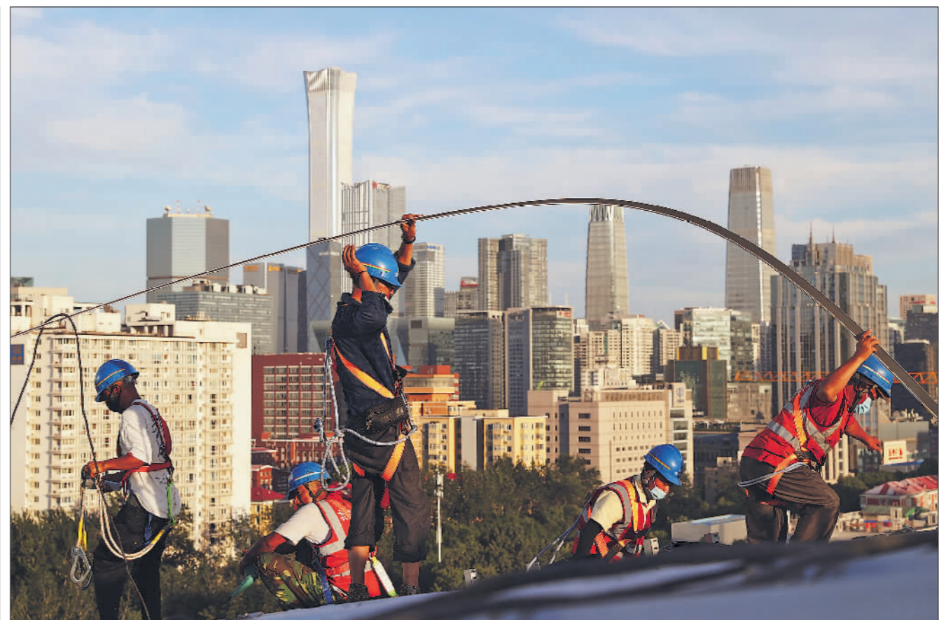
7月18日傍晚,在北京工人体育场改造重建工程的顶棚上,工人们在太阳的余晖下作业。始建于1959年、曾为首都“十大建筑”的北京工人体育场即将迎来新生。
