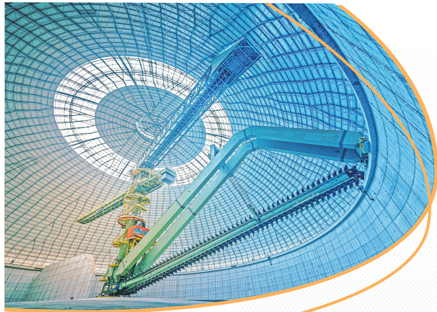
智能“无人化”料场,实现了经济、环保、高效、智能运行。
