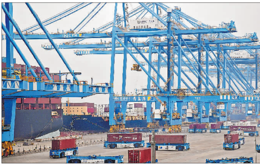
作业中的山东港口青岛港全自动化集装箱码头(10月16日摄)。据了解,该港正攻关更多关键核心技术,努力打造世界一流海港“中国样本”。新华社记者 李紫恒 摄
