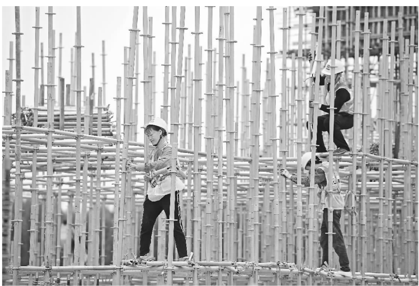
9月20日,工人在南宁国际铁路港电商物流区施工。当日,南宁国际铁路港电商物流区快运处理1号仓主体完工。南宁国际铁路港电商物流区总投资超过10亿元,分为快运处理仓、速运处理仓两个作业型仓库集群。南宁国际铁路港作为衔接“一带一路”的关键性物流枢纽节点,是广西深度参与建设西部陆海新通道重要项目之一。
