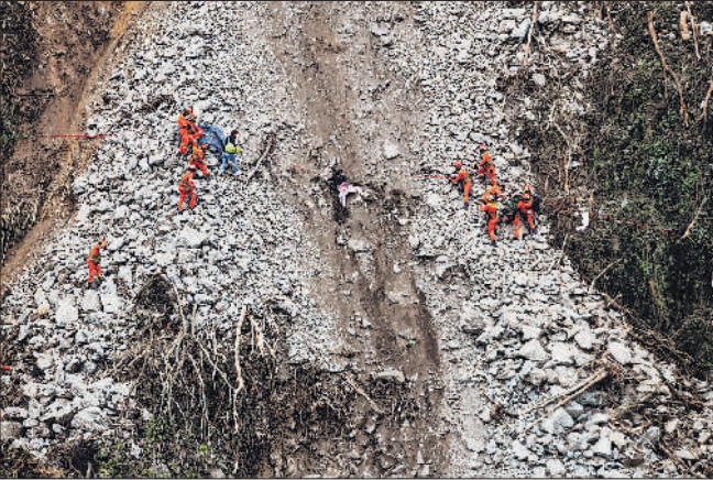
9月6日下午,泸定县海螺沟大桥附近,地震导致的山体滑坡使海螺沟景区通往磨西镇的道路中断,救援人员用绳索和身躯“搭”起救援通道,帮助群众穿过塌方路段。 华小峰 摄
