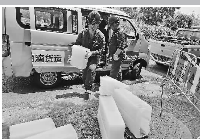
关惠方所在班组正在搬运冰块为线沟电缆降温。
