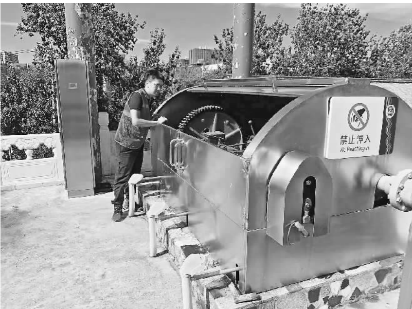
8月21日,刘继琨在松林闸检查闸启闭设备。
