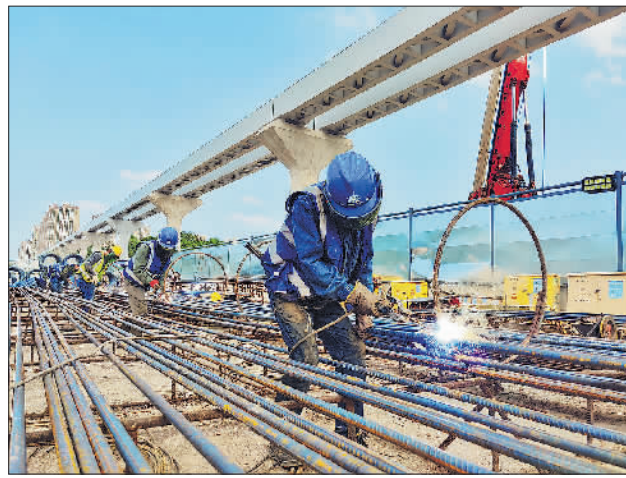
“五一”期间,深圳地铁16号线坪山站施工现场,中铁十九局轨道公司建设者坚守岗位,高质量、高标准、高效率完成附属结构入口围护桩施工和地连墙切割作业任务。 张振宇 黄瑶 摄
