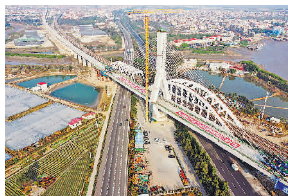
新建福厦铁路木兰溪特大桥斜拉桥主梁合龙
