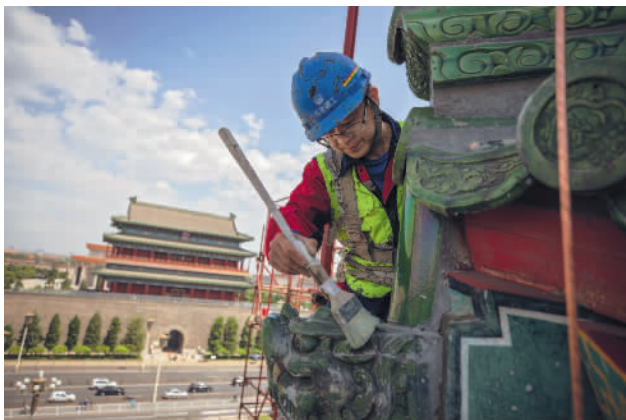
5月26日上午,北京正阳门箭楼修缮期间,席红军师傅正在用刷子清扫屋檐上的灰尘。
