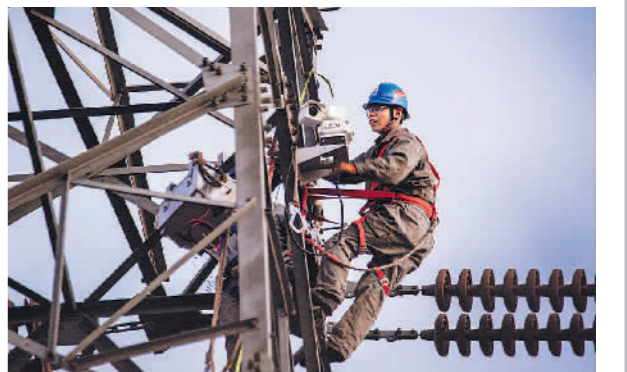
国网廊坊供电公司员工新胜利在高塔上安装5G监控设备。
