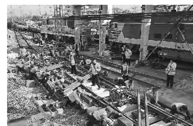
为提高鹰潭机车存车线限制区段通过能力，为沪昆铁路电煤运输等提供更好的运力保障，连日来，国铁南昌局集团下属相关单位组织160名职工对沪昆铁路鹰潭机车存车线35组道岔及线路设备进行全面改型升级。改型升级后的线路牵引机车日均出发量将得到动态提升。图为11月24日，工人们正在沪昆铁路鹰潭机车存车线进行道岔改型升级施工。（胡国林 谢海峰 摄）
