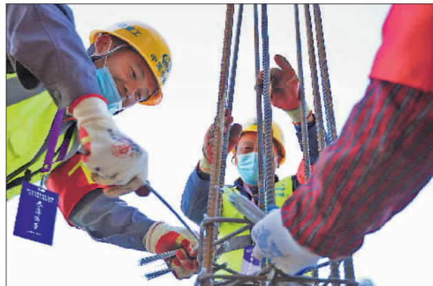
钢筋绑扎工争“状元”
