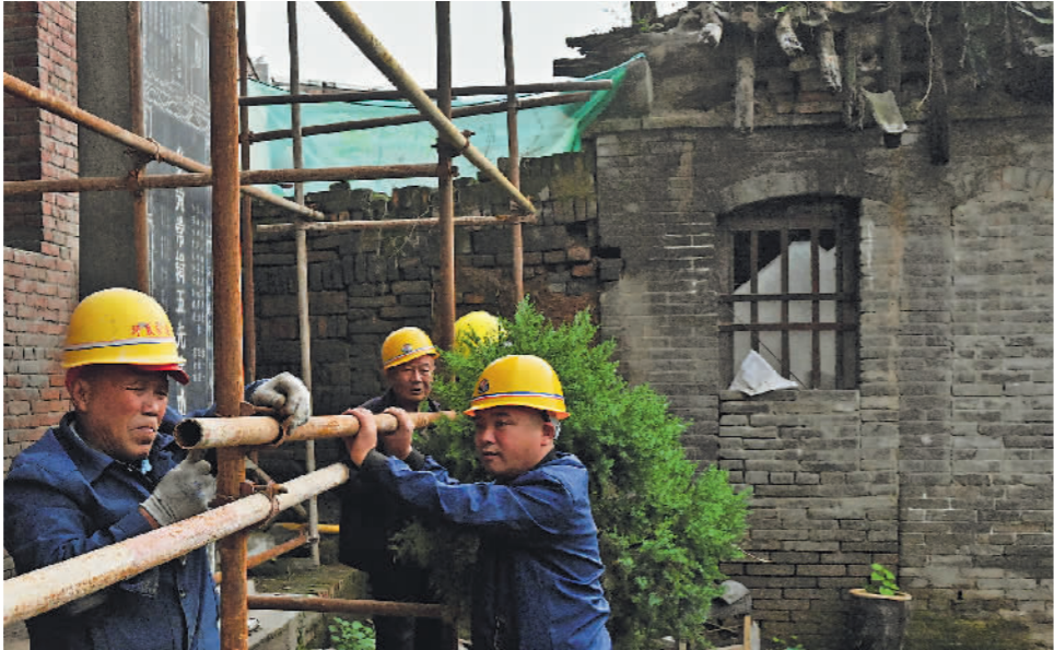
10月13日,工人在山西省洪洞县苗村祖师庙搭建脚手架,准备开展修缮工作。 新华社记者 马毅敏摄
