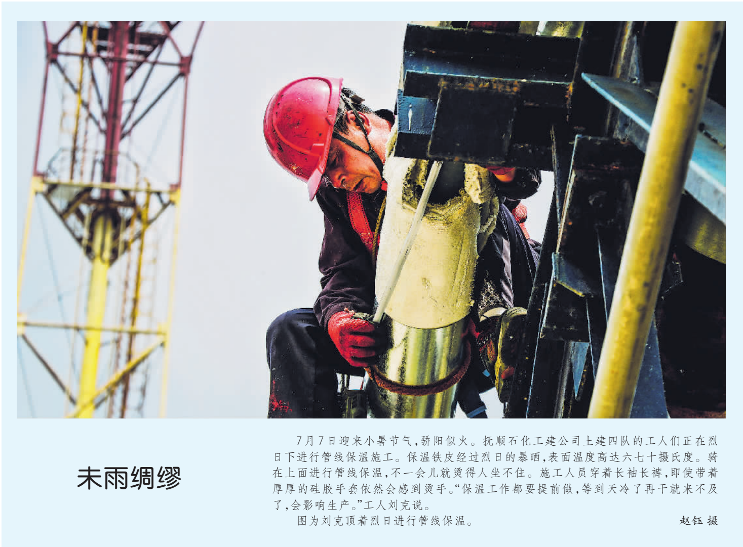
7月7日迎来小暑节气,骄阳似火。抚顺石化建工建公司土建四队的工人们正在烈日下进行管线保温施工。保温铁皮经过烈日的暴晒,表面温度高达六七十摄氏度。骑在上面进行管线保温,不一会儿就烫得人坐不住。施工人员穿着长袖长裤,即使带着厚厚的硅胶手套依然会感到烫手。“保温工作都要提前做,等到天冷了再干就来不及了,会影响生产。”工人刘克说。 图为刘克顶着烈日进行管线保温。 赵钰 摄
