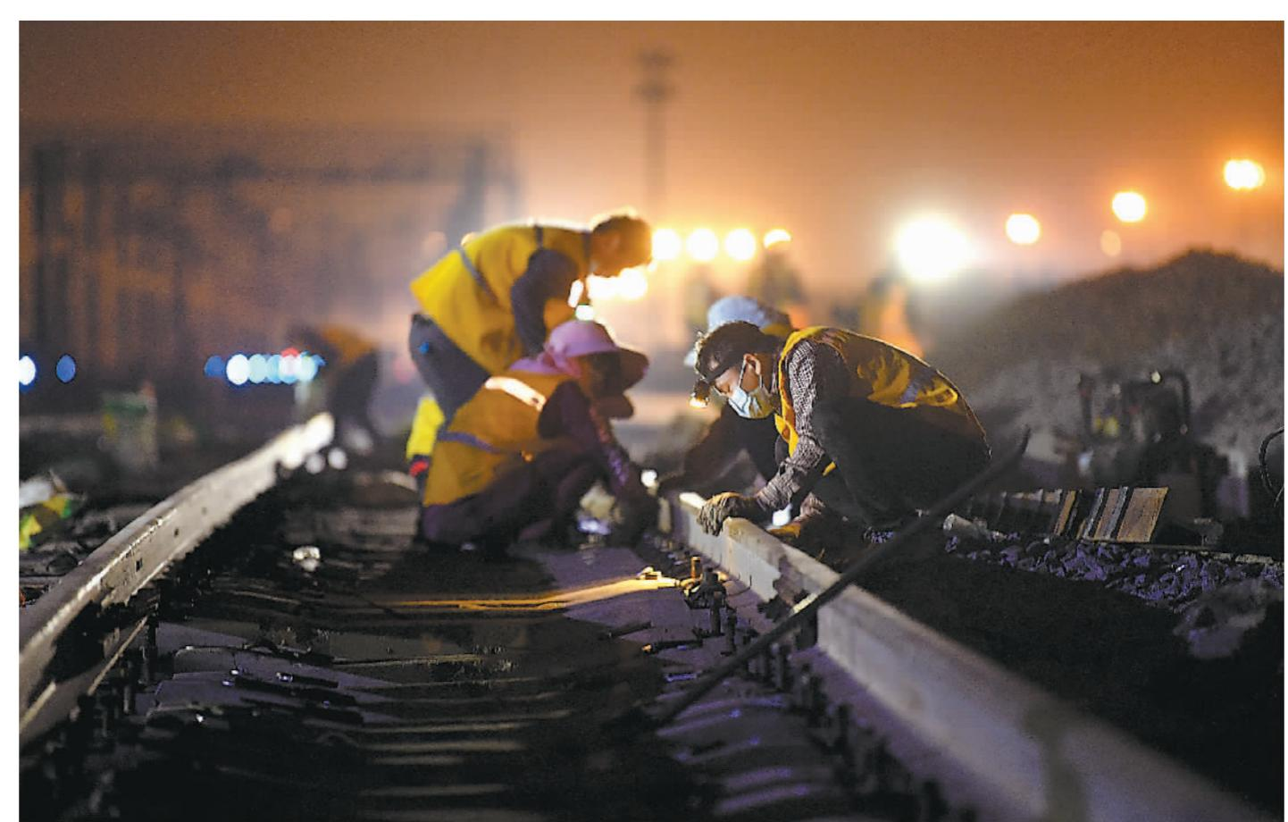
1月21日凌晨，在防城港第三进港线建设现场，铁路工人在上扣件紧固钢轨。
