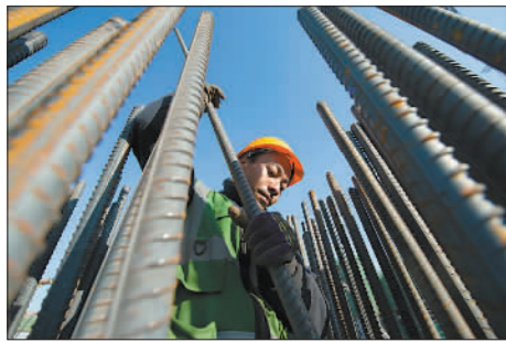
12月4日,钢筋工杨洪在容东片区安置房项目上绑扎立柱。
