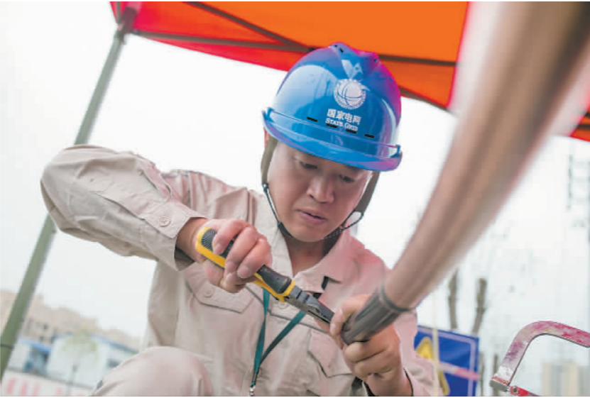
程颖正在进行10千伏电缆终端头制作。
