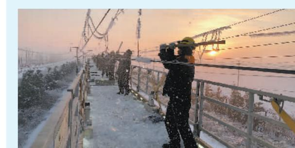
11月18日以来,受大范围雨雪冰冻天气影响,长珲高铁全线因接触网覆冰,无法保证电力机车正常供电。经过上千名铁路职工连续4昼夜不间断除冰,到22日全部清除完毕。23日上午,长珲高铁恢复通车。
