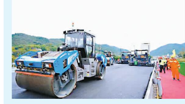
10月22日,浙江黄衢南高速衢州段举行无人智能化集群施工现场会。无人机群错位搭配,联合摊铺作业。无人机群采用的自动驾驶技术、3D自动摊铺技术等智能技术让路面平整度大大提升,多重安全系统也能够实现智能防撞,保证施工安全。
